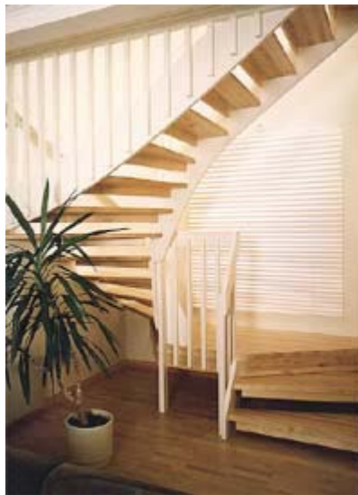
Kaide sisäänporatulla kiinnityksellä (P) ja käsijohteella H2
